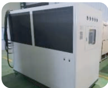
伺服節能冷水機 (2024.9.1安裝完成)
